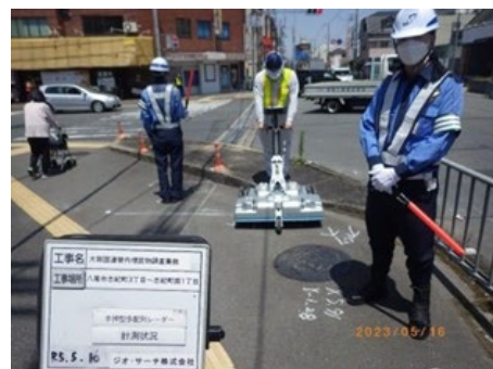
図6 現地調査状況
