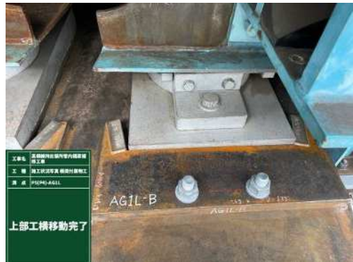
写真7 移動完了時橋座状況
