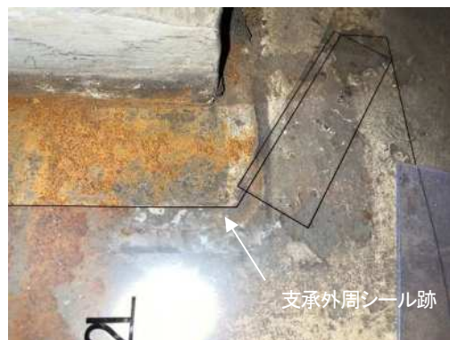
写真-3 ガイドプレート製作実測状況
