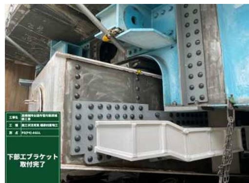
写真-1 梁端部ブラケット構造
