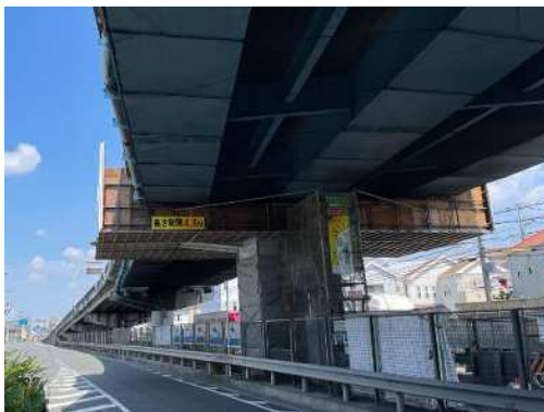
写真5 施工足場設置状況
