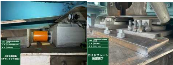
写真-2 横移動構造
