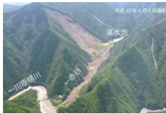
写真-1 赤谷地区 被害直後
