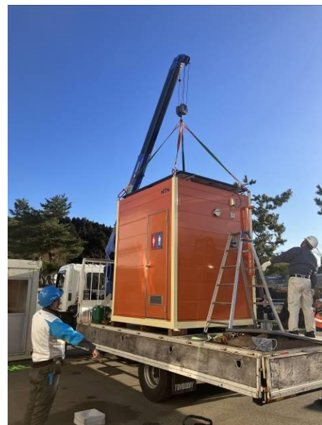
写真-3 循環式トイレの設置
