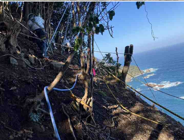
写-2 ラス張の状況
