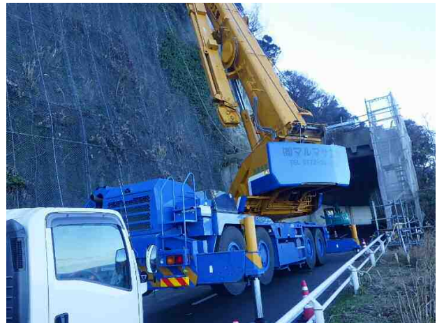
写-3 落石防護網の設置状況
