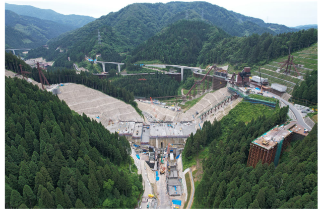
写真-1 ダム本体工事進捗状況写真(2024年6月撮影)
