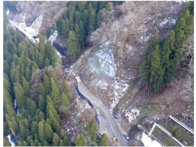
写真-5 地山崩落箇所の工事完成後(2024年3月撮影)
