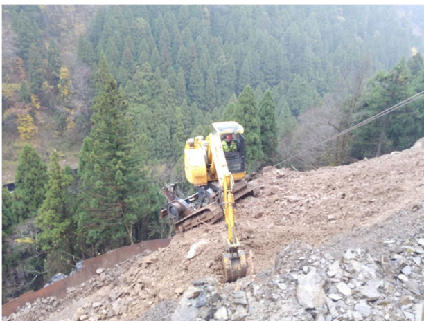
写真4 高所法面削岩機を活用した施工状況 (2024年1月撮影)
