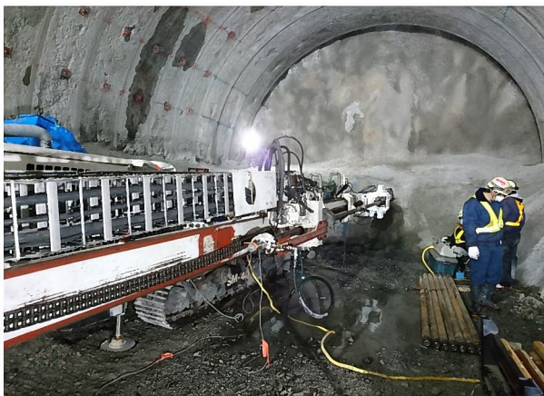
写真-3 先行ボーリングの実施状況
