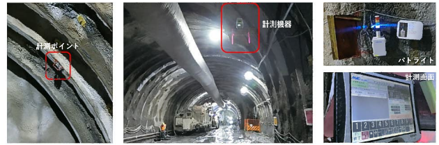
写真-6 パトライト設置状況写真
