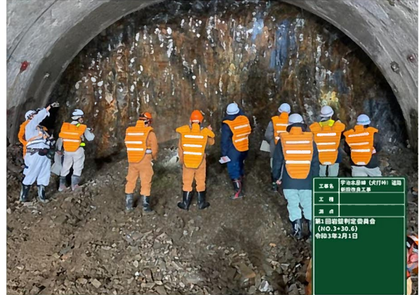
写真-2 岩盤判定委員会の状況写真
