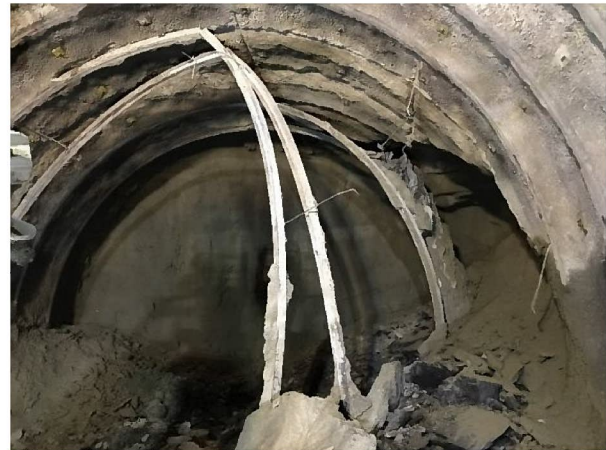
写真-5 支保崩壊状況写真
