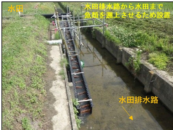
水田魚道 設置：5月11日、通水：5月30日 一時撤去(大雨)：6月2日 再設置：6月5日、再通水：6月8日 撤去：6月15日
