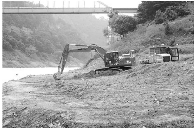
図-7 高山ダム堆砂除去工事
