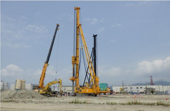
写真-4 機械攪拌の作業
