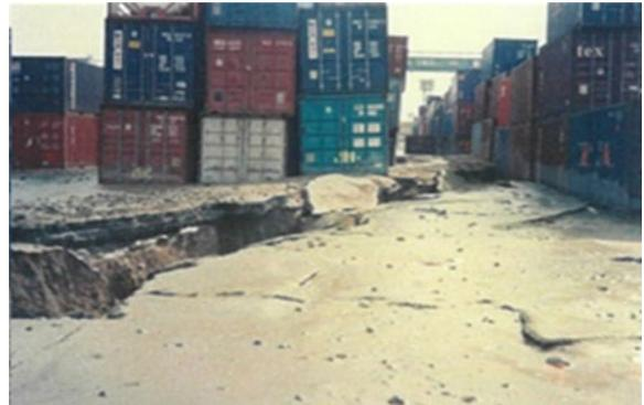
写真-1 液状化したコンテナヤード
