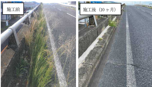
図-7 手法C, D施工箇所の対策前後の写真
