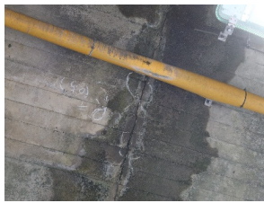
写真4. 漏水(側壁部)
