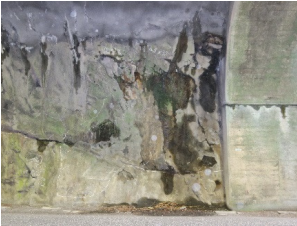
写真5. 漏水(天端部)
