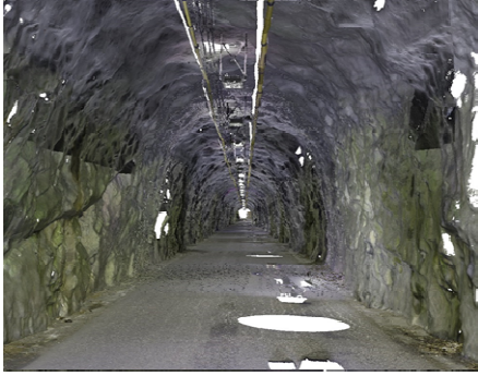
写真2. 小口第二トンネル内部
