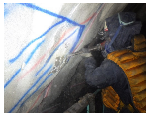
写真7. 既設モルタル撤去
