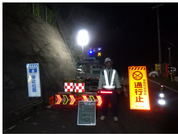
写真11. 通行規制状況
