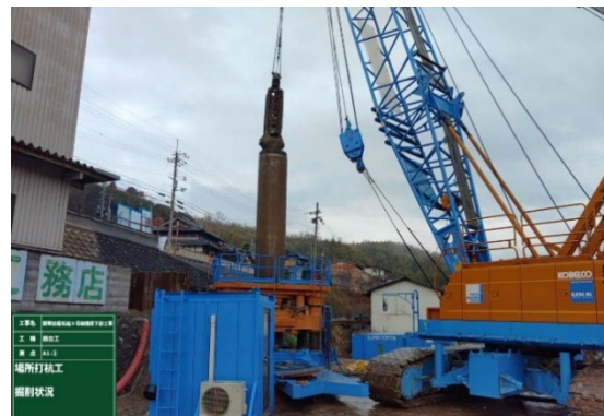
写真 5 杭基礎打設状況
