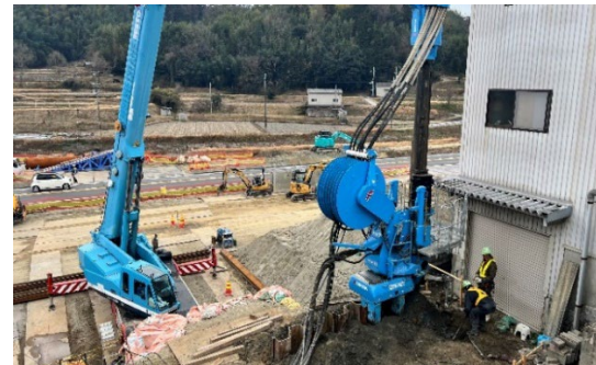
写真 4 鋼矢板圧入状況
