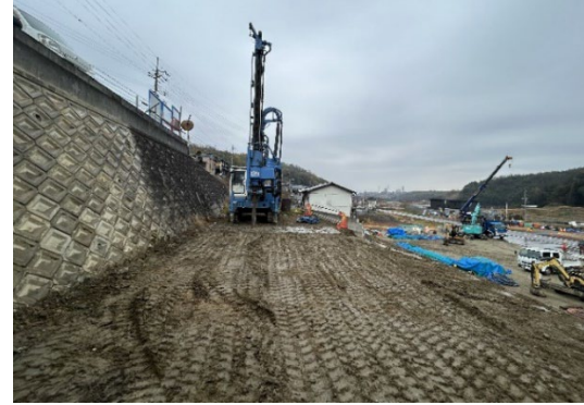
写真 3 地盤改良施工状況
