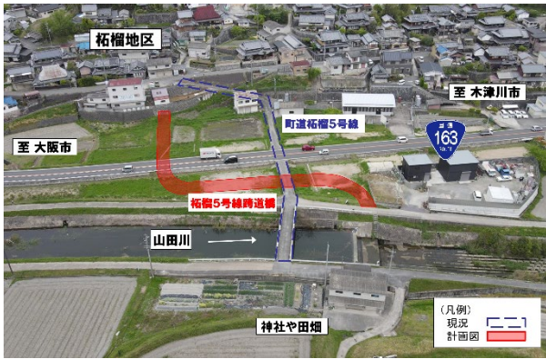
写真 1 柘榴5号線跨道橋付近状況写真
