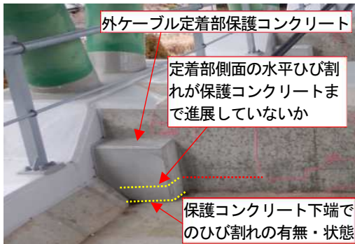
a) 外ケーブル定着部(外ケーブル定着側)
