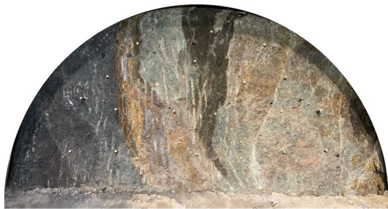
写真-2 第1 破碎帯の切羽状況 (TD3,231m)
