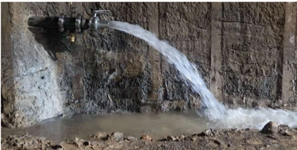
写真-4 長尺ボーリング湧水状況 (TD3,497m)
