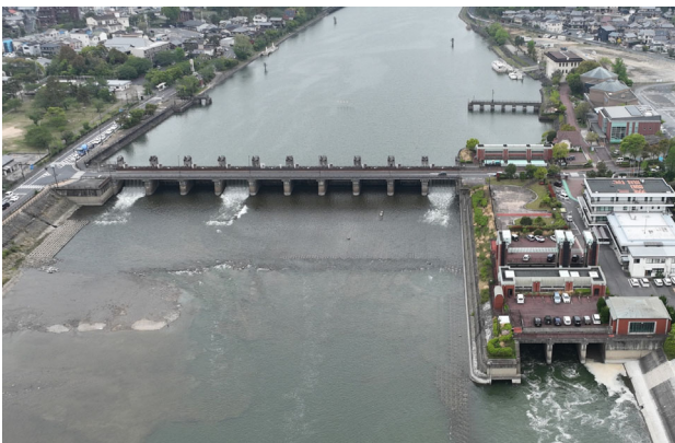
写真-1 瀬田川洗堰放流設備
