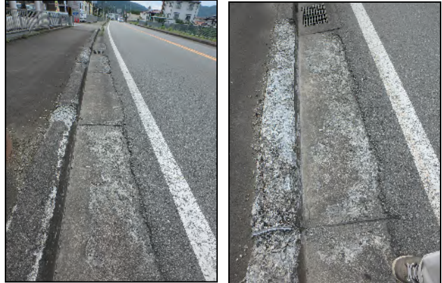
図8 宮田での一リング発生状況
