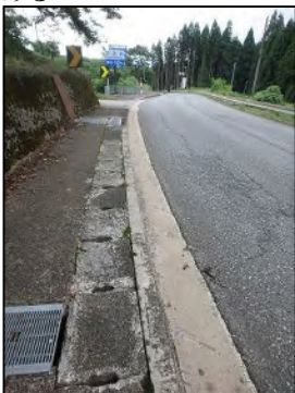
図7 黒田でのスケーリング状況写真
