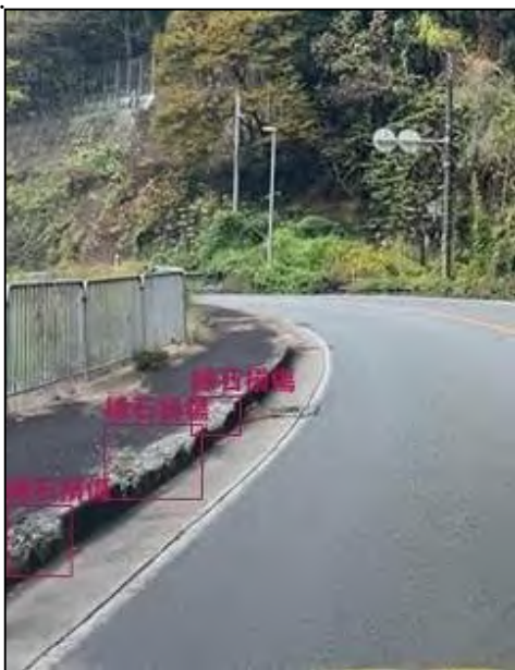
図-12 AIによる損傷状況の認識結果
