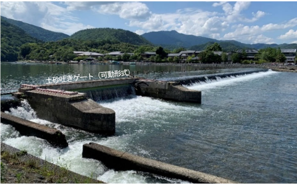
写真4 現在の一の井堰
