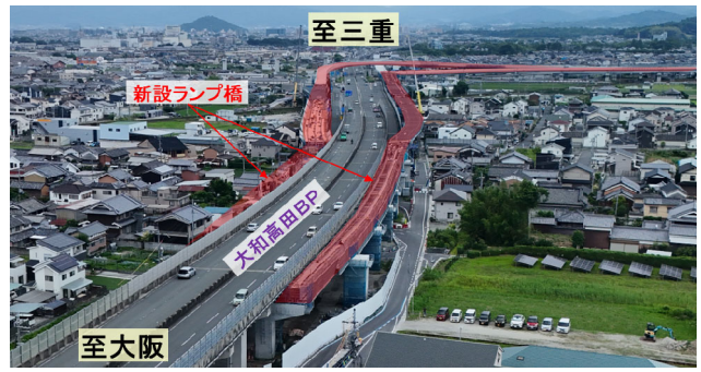
図-10 大高BP車線幅規制箇所の状況
