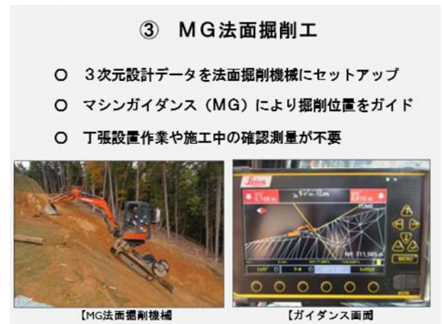
図-5 MG法面掘削工の施工状況
