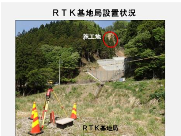
図-8 R T K 基地局と施工地
