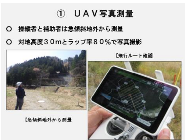
図-3 UAV写真測量状況
