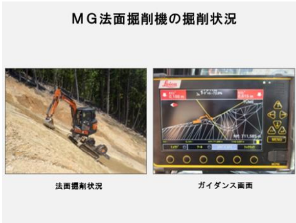
図-6 MG法面掘削工の施工状況
