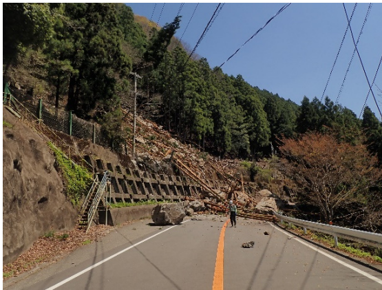
図-2 長殿の崩土被災状況
