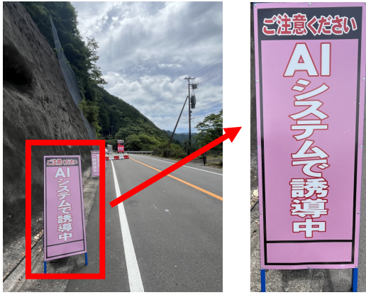
図-7 予告看板の設置状況
