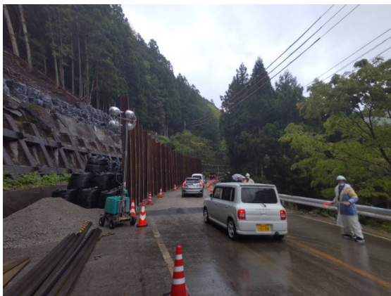
図-3 交通解放時の誘導状況
