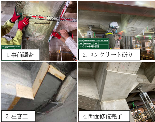
写真4 上部工の断面修復施工手順
