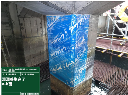
写真5 脚柱部養生状況
