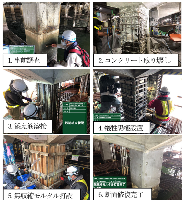
写真-3 脚柱部の断面修復施工手順
