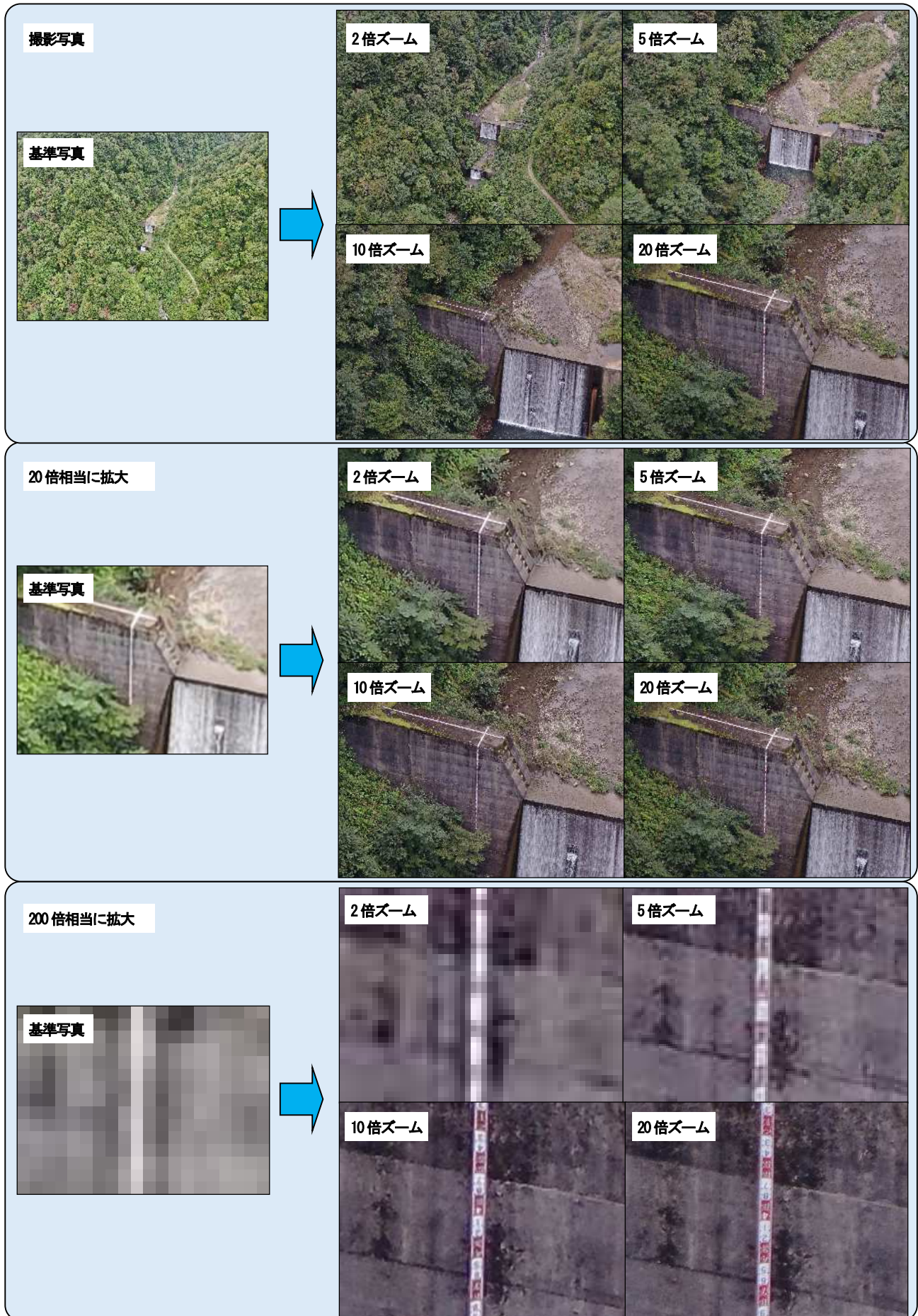
図-6 基準写真及びズーム写真 (上：撮影写真，中：20倍相当に拡大，下：200倍相当に拡大)
