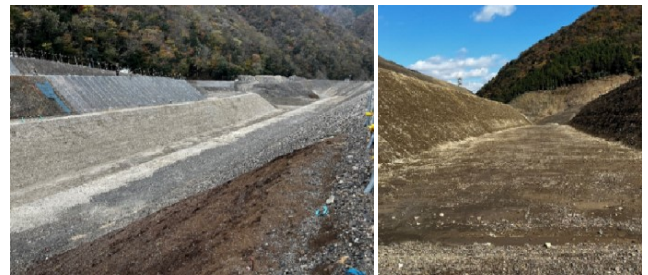
図-11 無人化施工による溪流保全工出来形
