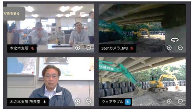
写真-12 リモートを併用した現場パトロールの様子
