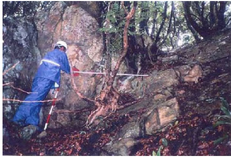
写真-1 亀裂間に設置したピン間計測の例
