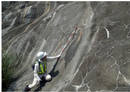
写真-2 目視点検の例
