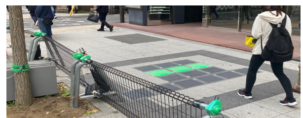
図-15 路面太陽光パネルの設置状況
