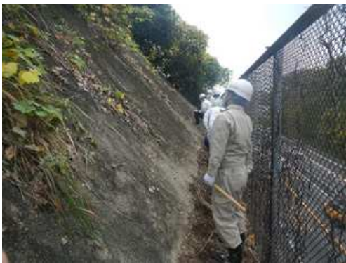
図-2 国道1号防災カルテ箇所の点検と診断
