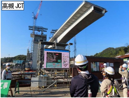
NEXCO新名神 淀川橋 施工現場見学
