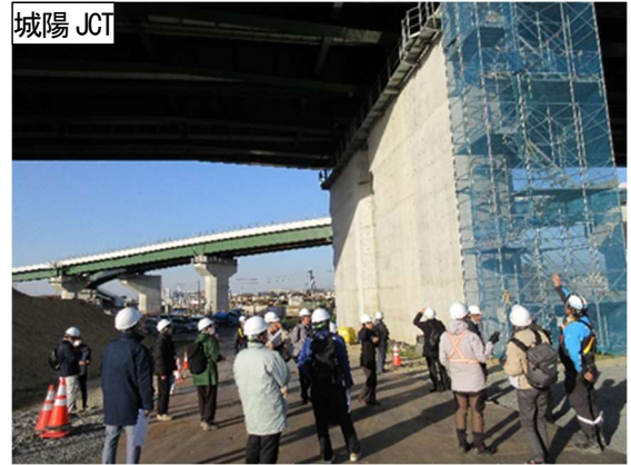
道路橋 基礎工勉強会（現国総研 七澤道路構造物管理システム研究官）
