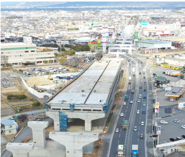
図-2 橿原高田 IC 北側の施工状況（R4.2 現在）
