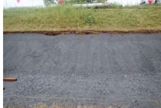
図-2 砕石養生の事例
