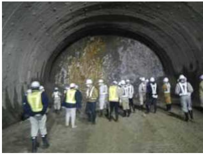
図-7 大野油坂道路新長野トンネル工事
