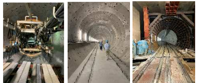
図-10 北大阪急行延伸部シールド工事現地勉強会
