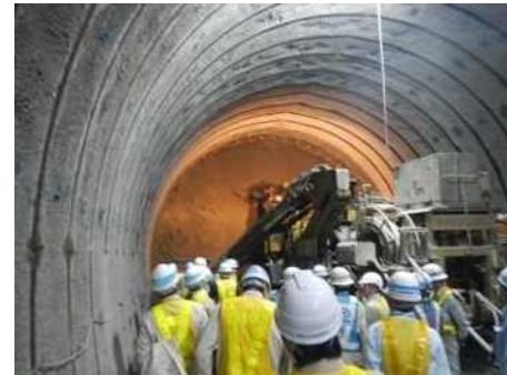
図-5 川辺第二トンネル工事現場視察
