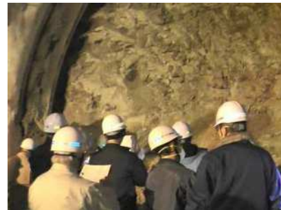
図-2 新田東佐味トンネルにおいて岩判定を実施
