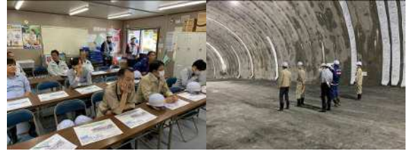
図-13 すさみ串本道路NATM工法現地勉強会
