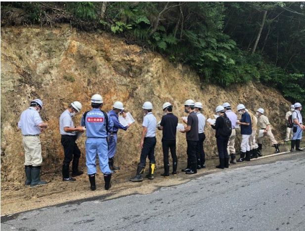
写真-3 大戸川ダム第四期断層の地表調査
