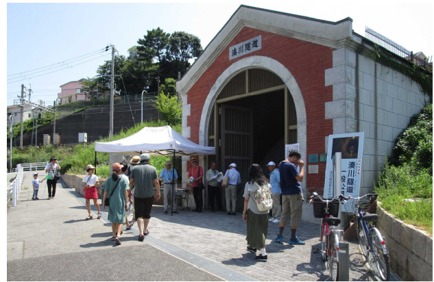
写真2.1 湊川隧道門扉（定期一般公開時）
