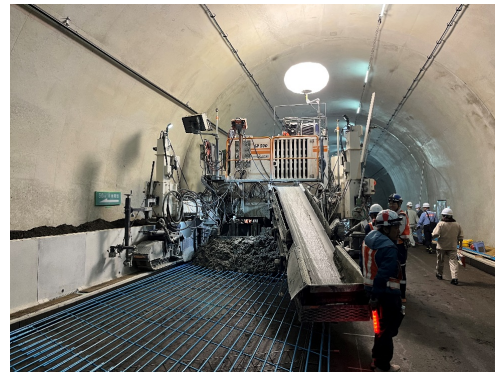
写真-4 現場見学会 国道9号 笠波トンネル舗装工事
