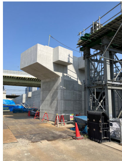
写真-5 現場見学会 環境配慮型コンクリート 阪神高速道路淀川左岸線2期
