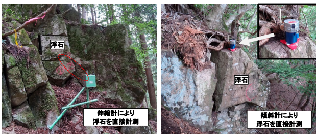
図-12 変位計によるモニタリング状況
