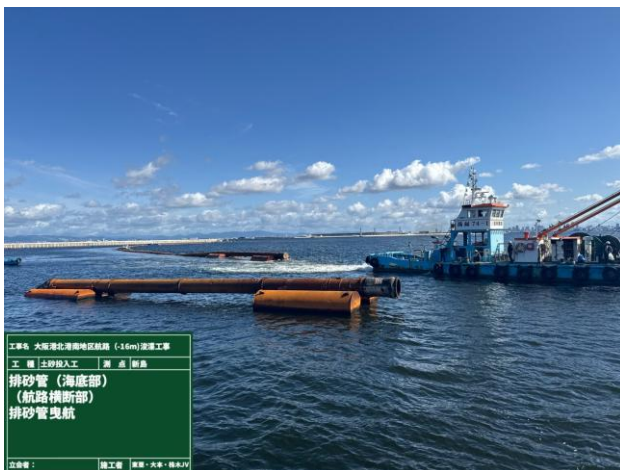
写真-4 排砂管曳航の様子
