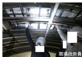
図-24 補強鉄筋の設置
