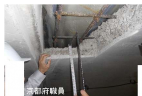
図-22 はつり落とし工
