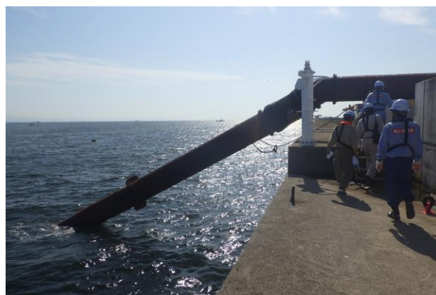
写真-2 立ち上がり零号の様子
