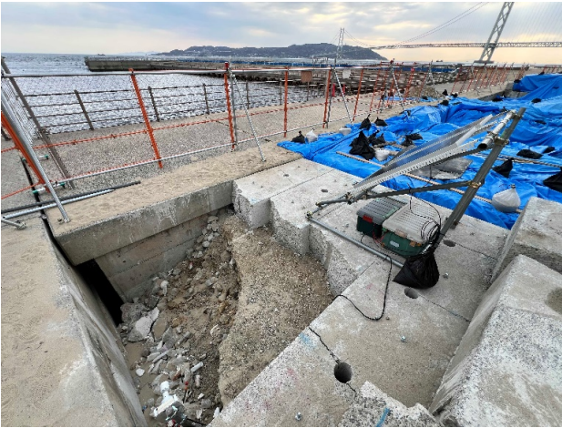
写真-1 空洞確認箇所の開削状況
