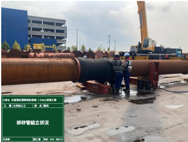
写真-3 排砂管組立の様子
