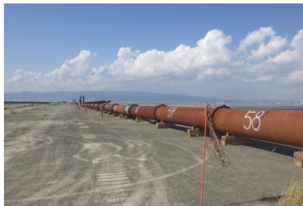
写真-1 陸上管の様子
