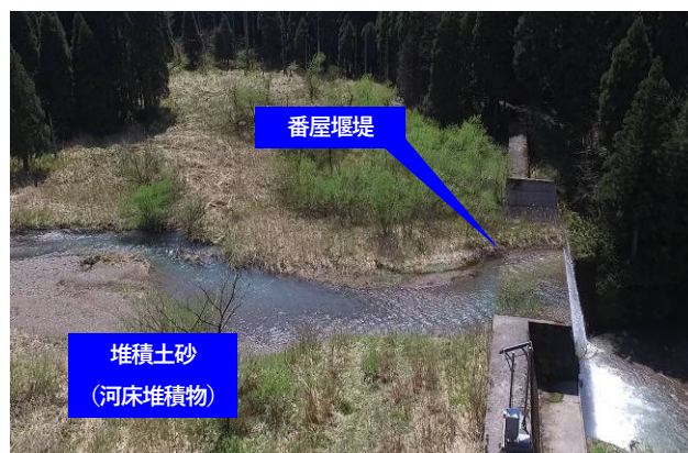
写真-1 番屋堰堤（既存）
