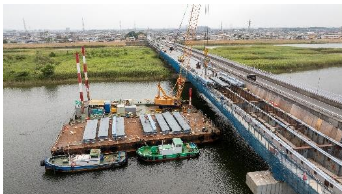
図-9 クレーン付き台船使用状況
