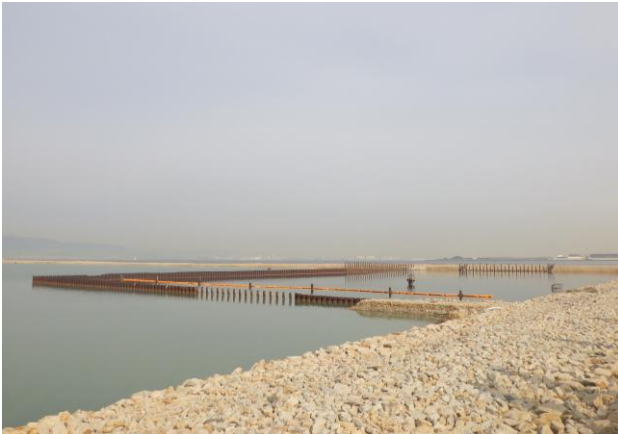
写真-6 新島内の沈殿池
