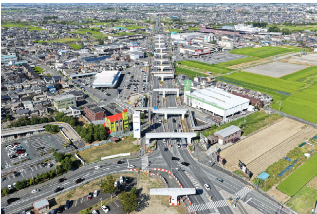
図-1 曲川町7丁目南交差点の上空写真
