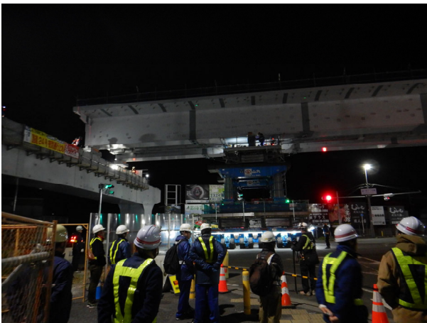
図-14 多軸式特殊台車を用いた架設
