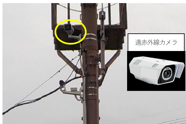
図-3 観測機器の設置状況
