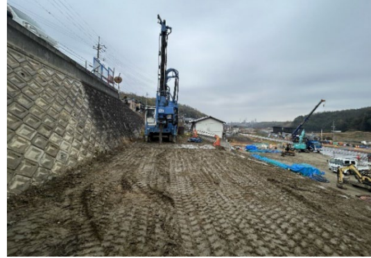
写真 3 地盤改良施工状況
