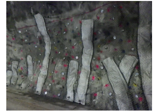
写真8. 排水マット設置
