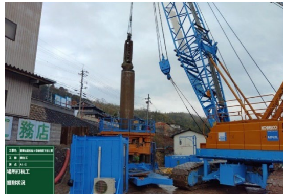
写真 5 杭基礎打設状況
