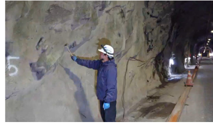
写真6. 打音調査の実施状況
