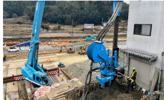
写真 4 鋼矢板圧入状況
