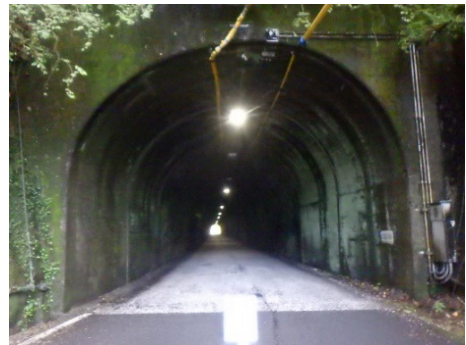
写真1. 小口第二トンネル坑口付近
