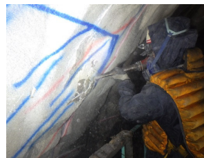
写真7. 既設モルタル撤去
