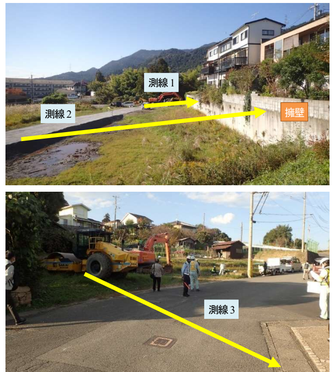
図6 起振源設置地点の状況
