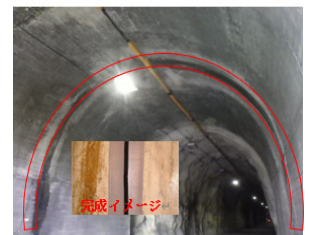
写真10. 線導水工の施工
