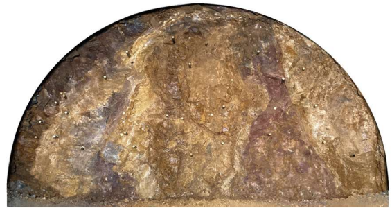
写真-3 第3破碎帯の切羽状況 (TD3,461m)
