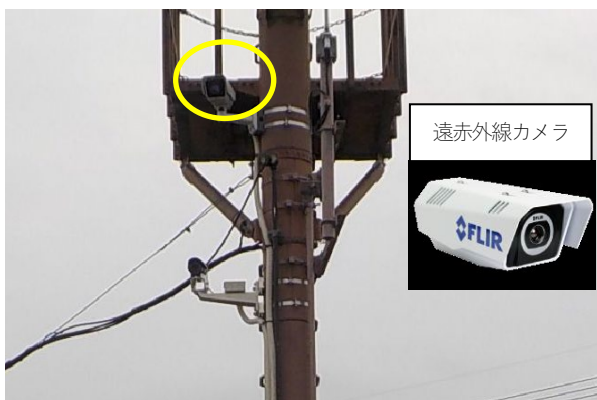
図-3 観測機器の設置状況
