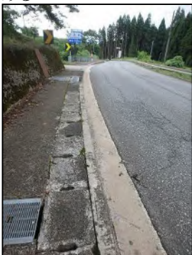
図7 黒田でのスケーリング状況写真
