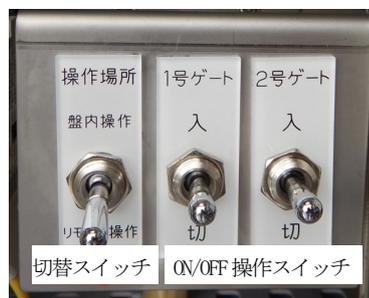
写真-4 切替スイッチ(左)とブレーカ ON/OFF 操作スイッチ(右)
