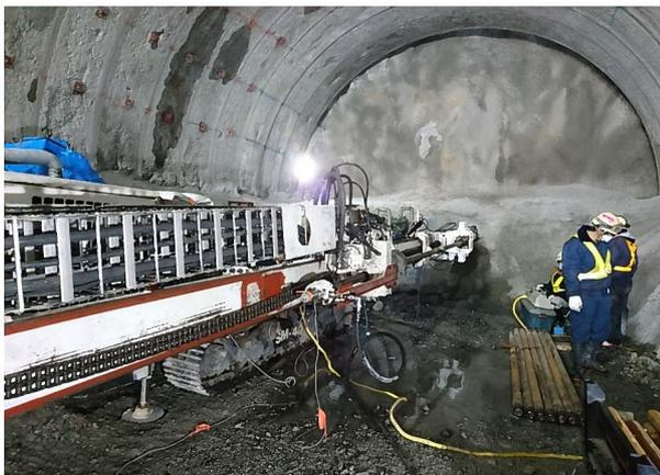
写真-3 先行ボーリングの実施状況
