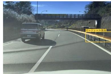
図-6 ガードレールの不具合検知例
