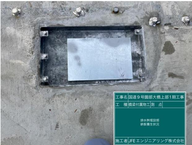
写真-7 排水柵鉄板養生状況
