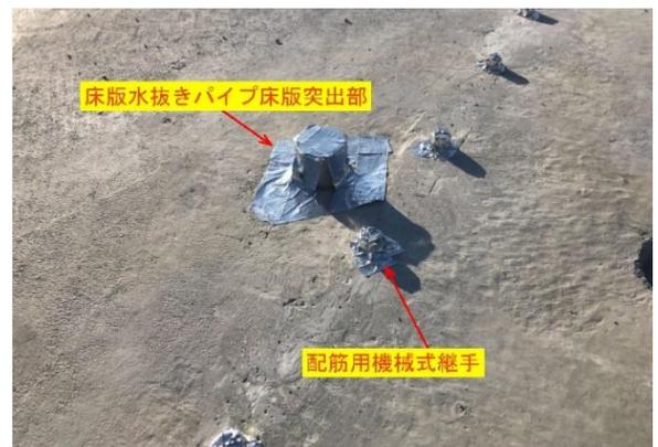
写真-6 機械継手養生状況
