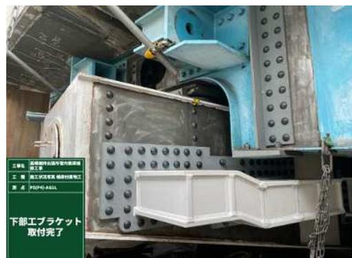
写真-1 梁端部ブラケット構造
