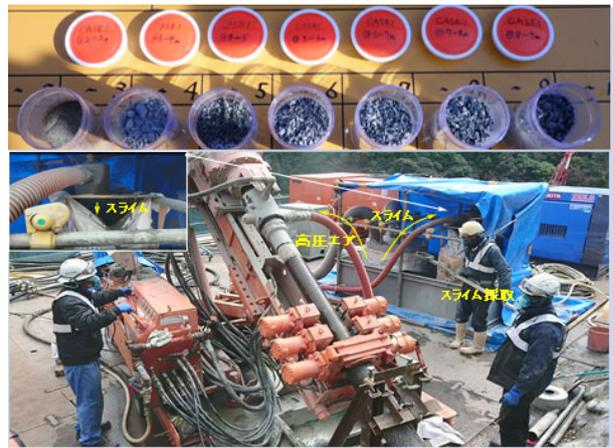
写真-3 削孔スライム採取状況
