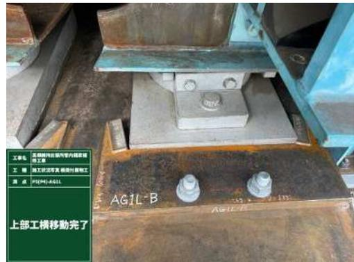
写真7 移動完了時橋座状況
