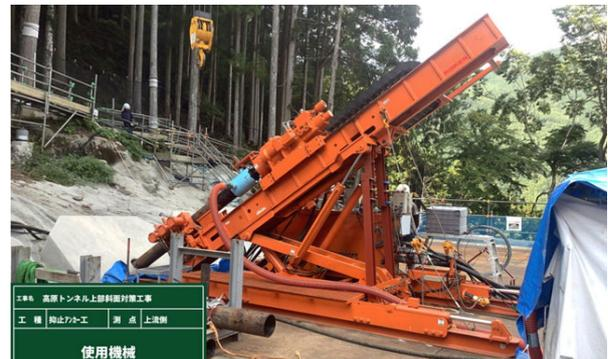
写真-1 ロータリーパーカッション式削孔機（165kW級）
