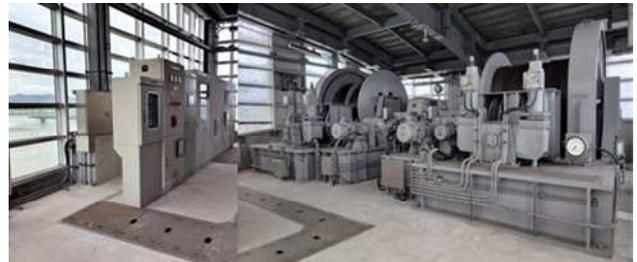
図-2 紀の川大堰ゲート機側操作盤と開閉装置
