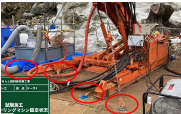
写真-2 削孔機固定状況
