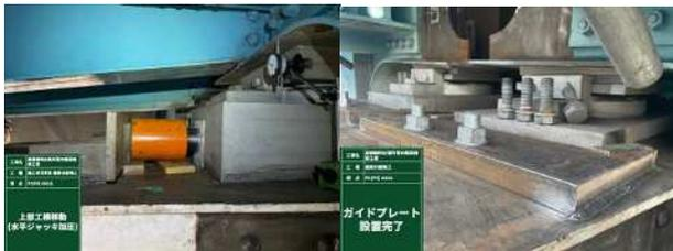
写真-2 横移動構造
