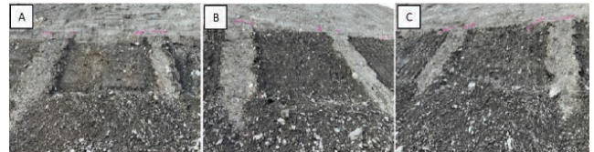
図-10 試行ヤードにおける法面整形作業出来形比較 (A. K-DIVE (大阪), B. K-DIVE (現場), C. 実機搭乗)
