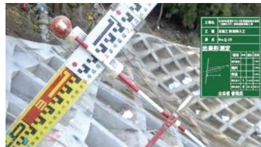
写真-3 ウェアラブルカメラによる目盛り確認の様子
