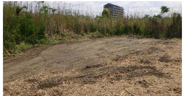
↑簡易代執行実施後状況
