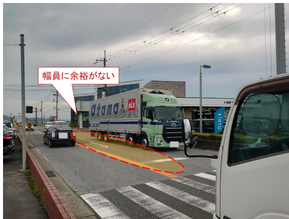
図-5 友定町交差点(流入2)の現地状況写真
