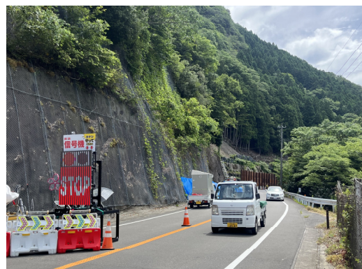
図-6 工事中の誘導状況
