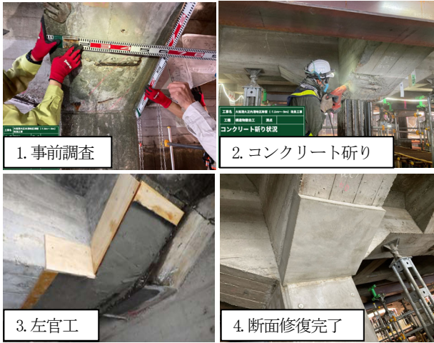
写真4 上部工の断面修復施工手順
