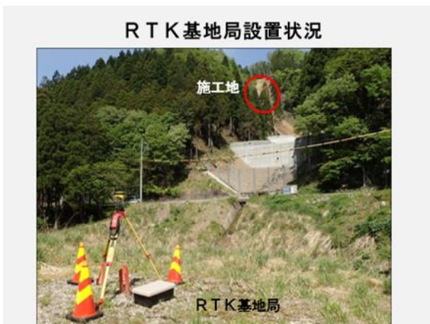
図-8 R T K基地局と施工地
