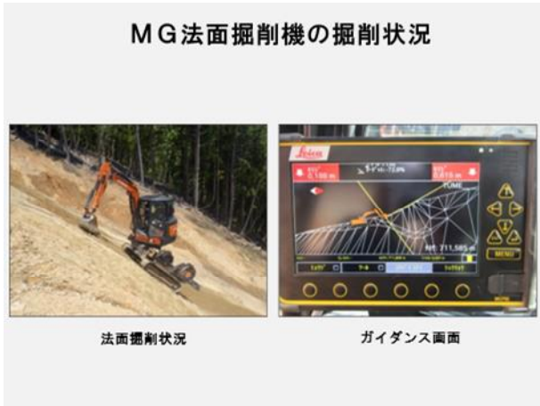
図-6 MG法面掘削機の施工状況
