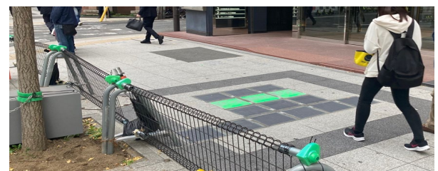
図-15 路面太陽光パネルの設置状況
