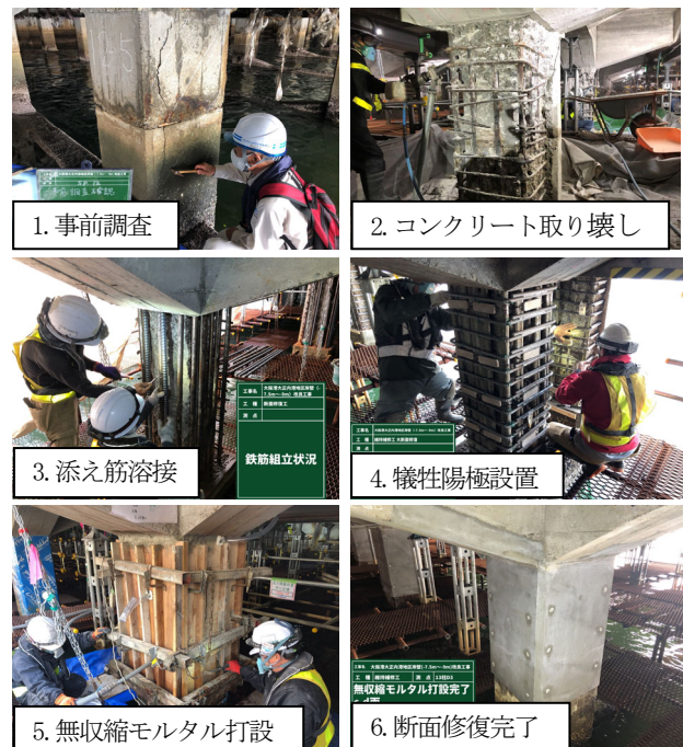
写真-3 脚柱部の断面修復施工手順
