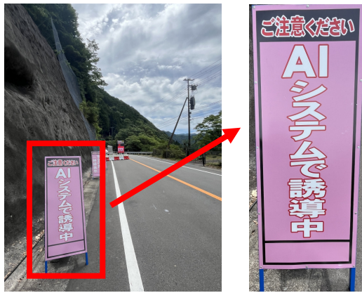
図-7 予告看板の設置状況
