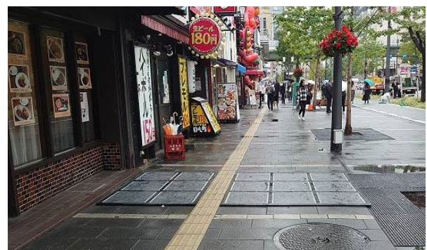
図-11 床発電の設置状況
