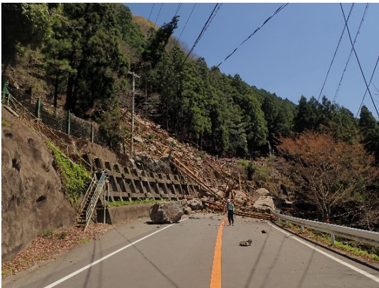
図-2 長殿の崩土被災状況
