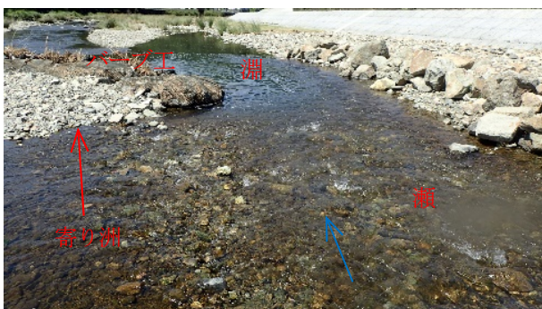
写真-4 バープ工設置後の状況
