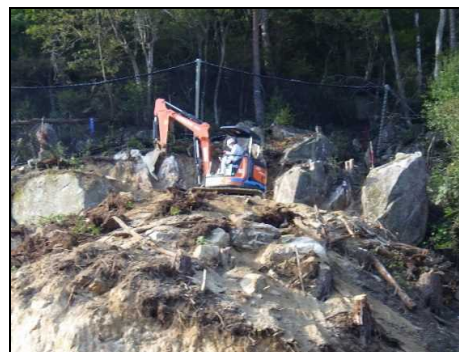
写真 - 3 転石を小割して撤去する状況
