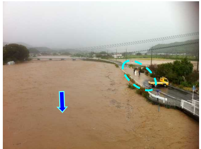
写真-2 霞堤への溢水状況(米原市西円寺 H24.9月)
