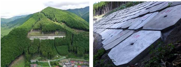
写真-2 現在の進捗状況 (左：航空写真、右：台座モルタル吹付完了)
