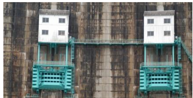
図-2 主放水ゲート設備近景写真
