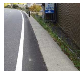
⑦張コンクリート
