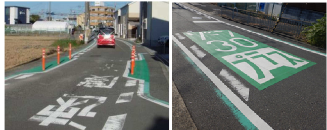
図-9 狭さくの設置状況(左)及び路面表示(右)
