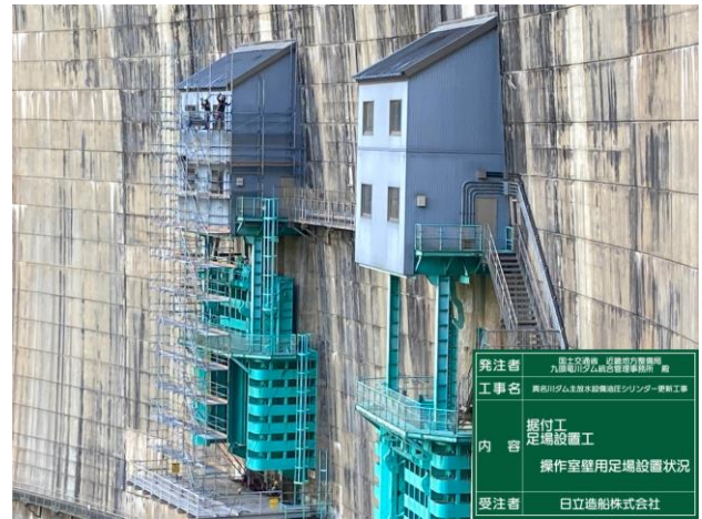
図-7 張り出し足場の活用状況
