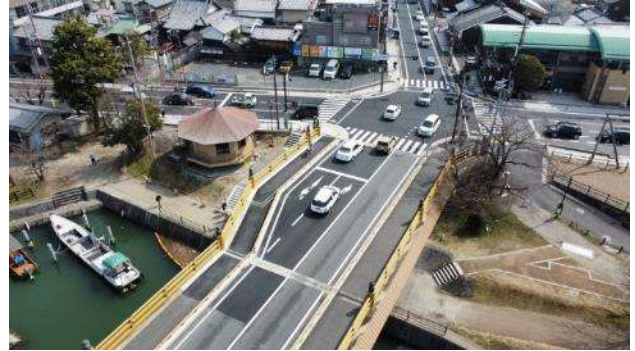
図-14 唐橋東詰交差点完成供用後の状況（令和4年4月）
