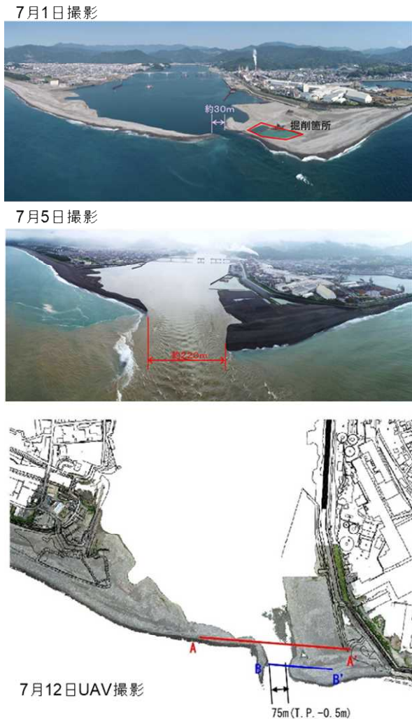
図-4 事前掘削箇所，フラッシュの状況
