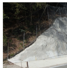
⑥モルタル吹付
