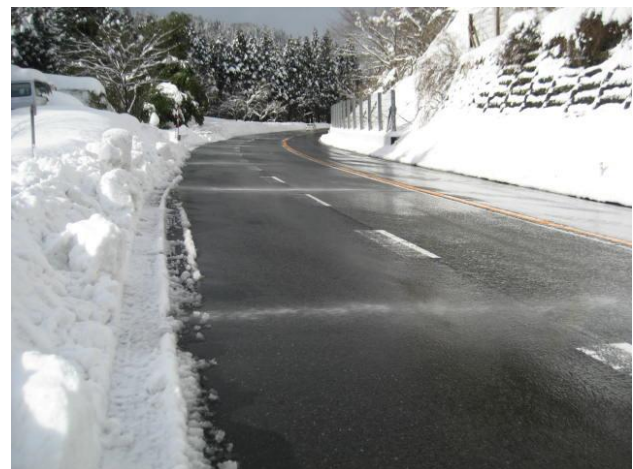
写真-2 散水融雪設備稼働状況
