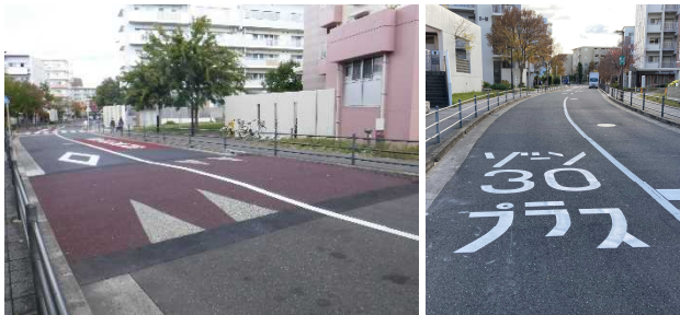
図-8 横断歩道手前のハンプ設置状況(左)及び路面表示(右)
