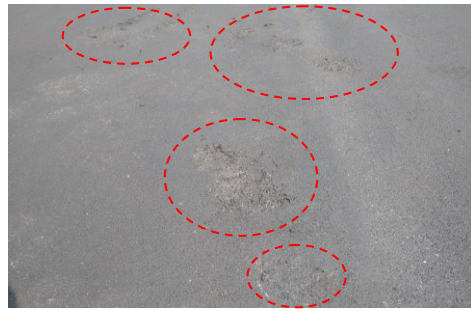
図-11 舗装面の荒れ
