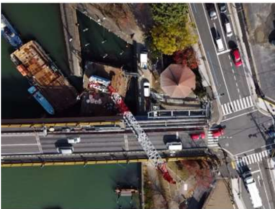
図-7 クレーン台船設置状況
