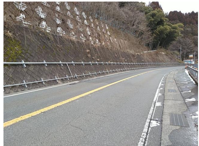
写真-1 散水融雪設備設置状況
