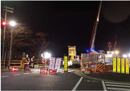
図-10 唐橋夜間通行止め状況写真
