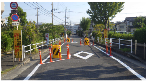
図-10 シケイン（クランク型）の設置状況
