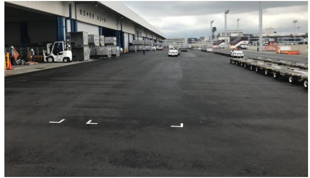
図-14 工事完了後の状況（エアサイド側）
