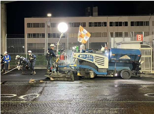
図-10 本施工の状況
