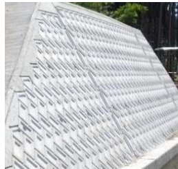
ブロック積擁壁
