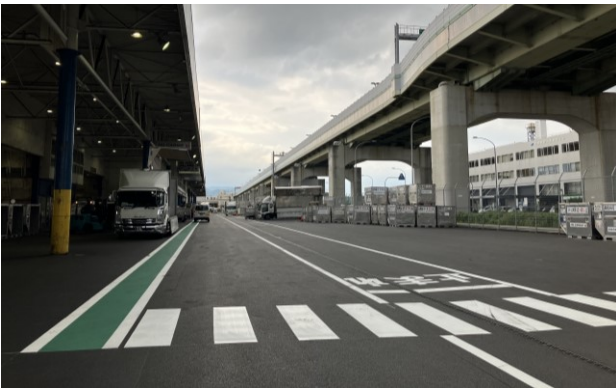
図-13 工事完了後の状況（トラックヤード側）
