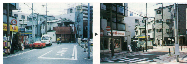
通過交通の流入ルートの先にある道路。手前から奥に向けての通過交通に対し、手前に向かう方向で一方通行規制を適用。コミュニティ道路としても整備。 出典：警察庁交通局建設省都市局・道路局監修「コミュニティゾーン実践マニュアル」(社)交通工学研究会2000年7月 17)
