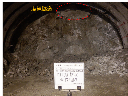
写真-2 旧 JR 隧道出現状況 2)
