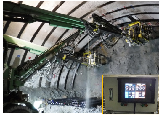
写真-3 切羽前方探査実施状況 3)
