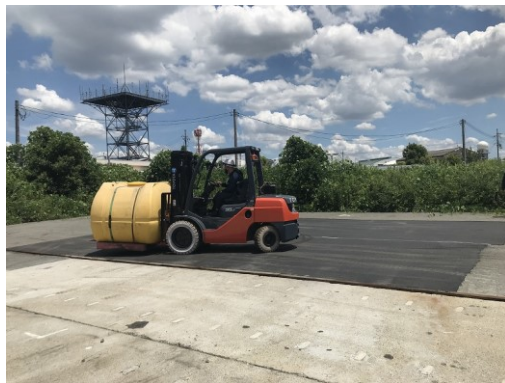
図-11 フォークリフト走行試験状況
