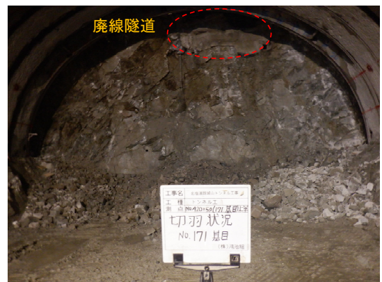
写真-2 旧 JR 隧道出現状況 2)
