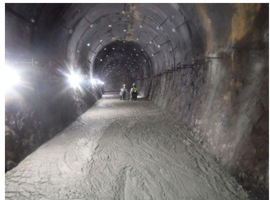
写真-1 トンネル閉塞工 (エアミルク充填状況) 2)
