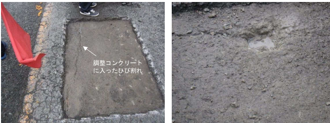
写-4 はつり調査状況
