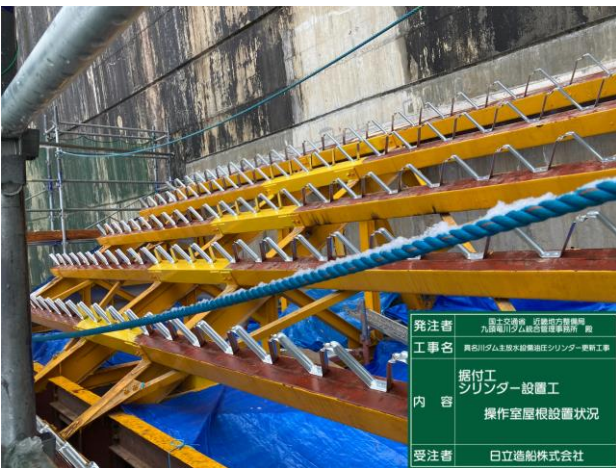
図-9 屋根復旧作業
