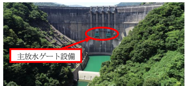
図-1 真名川ダム全体写真
