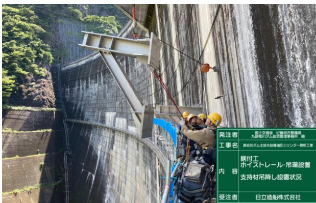
図-6 ホイストレール取付け状況
