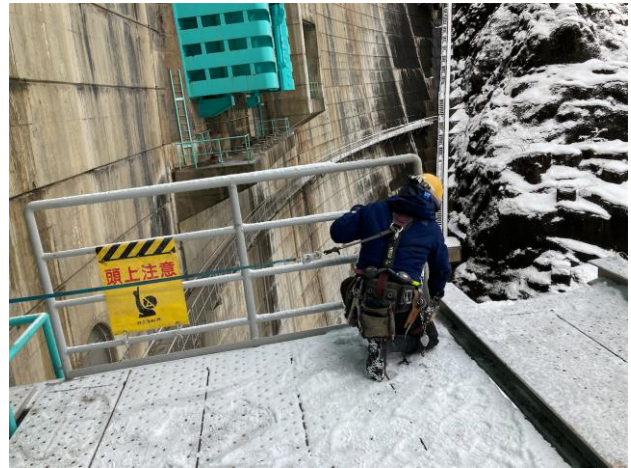
図-10 積雪開始直後の足場解体作業
