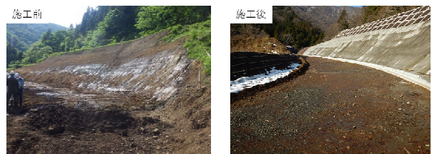
写真-3 橋梁上流部取付道路の法面对策
