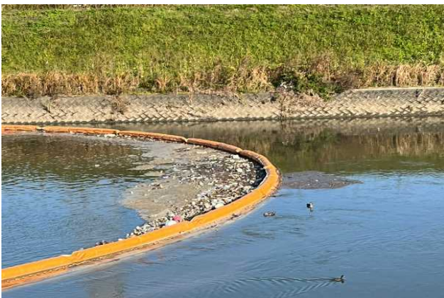
(図-6) 汚濁防止フェンスで捕捉したゴミの様子
