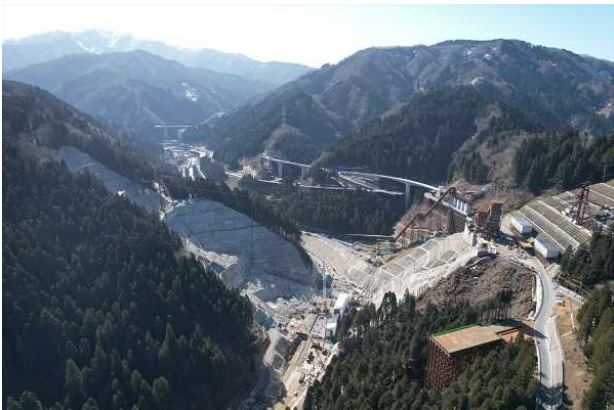
写真-1 堤体打設状況写真 (2023年3月)
