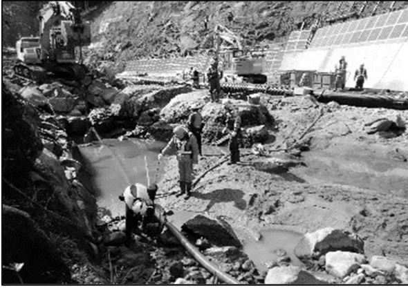
写真-2 流入水バイパス工事实施時の調査状況
