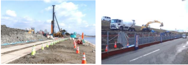
図-13 船着場及び裏のり面盛土工事
