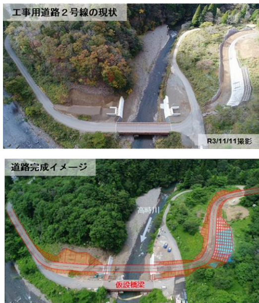
写真-2 工事用道路2号線の現状及び完成イメージ
